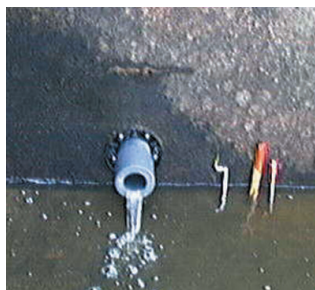
Figure 2 Tube de réduction de débit ajouté à la sortie de la conduite de débit réservé.
