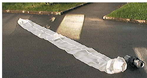
Figure 3 Filet de capture installé à la sortie de la conduite.
