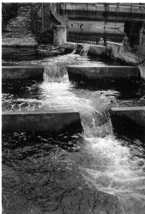
Photo 4 : Passe à échancrures demi-circulaire au barrage du Hom sur l'Orne
