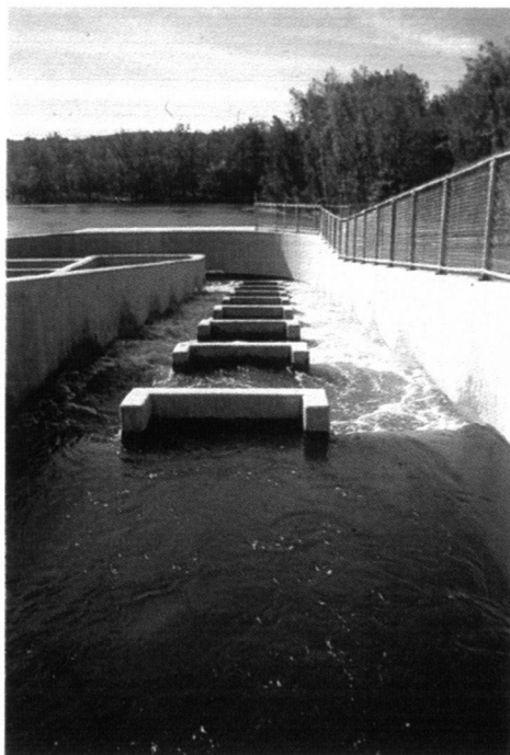
Photo 2 : Passe de type Ice Harbor au barrage de Vernon (rivière Connecticut, USA)
