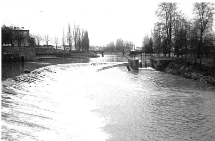
Photo 5 : Passe en écharpe sur la Vire à St-Lô (Manche).
