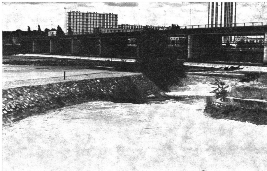
Photo 1 : Le barrage mobile de Vichy. Sur cette photo, les vannes sont levées. Au premier plan, la partie aval du parcours kayak.
