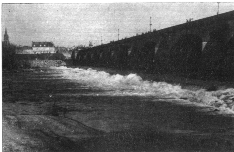
Photo 3 : LE PONT REGEMORTES A MOULINS (03), SUR L'ALLIER, en mars 1976.
