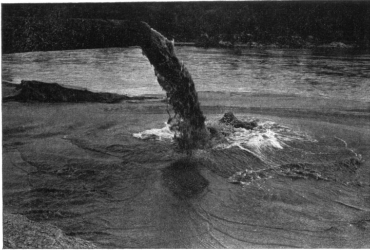
Photo 5 : UN REJET DIRECT D'EAU DE LAVAGE DES AGGREGATS DANS LA LOIRE (Cher, nov. 1976).
