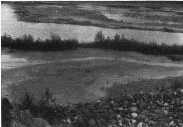
Photo 6 : UN BASSIN DE DECANTATION D'EAU DE LAVAGE, ENTIEREMENT COLMATE après quelques mois de fonctionnement, sur la Loire (Haute-Loire, 1975).
