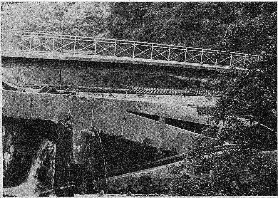
Fig. 1 — Vue aval du barrage, surplombé par une passerelle et par l'échelle à poissons.
