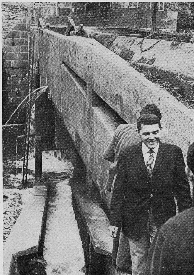
Fig. 2 — Vues des Volées amont et aval depuis le bassin intermédiaire.
