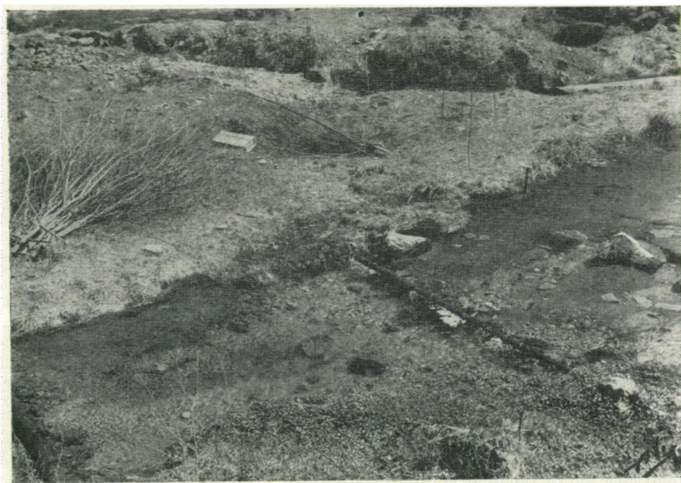
Pisciculture de Caunterets. — Barrage en rondins dans le bief naturel
