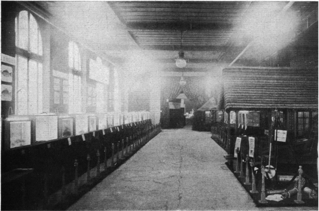
Fig. 4. — Vue d'ensemble (Galerie B).
